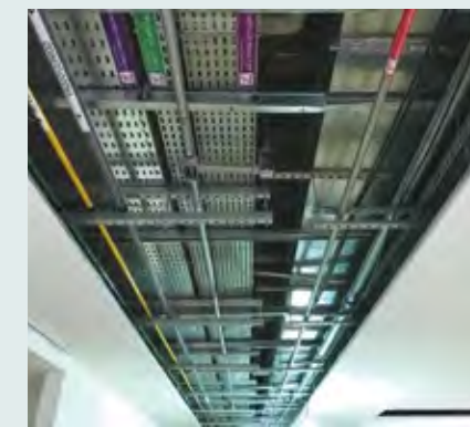
Instalações hospitalares em execução acima do forro
