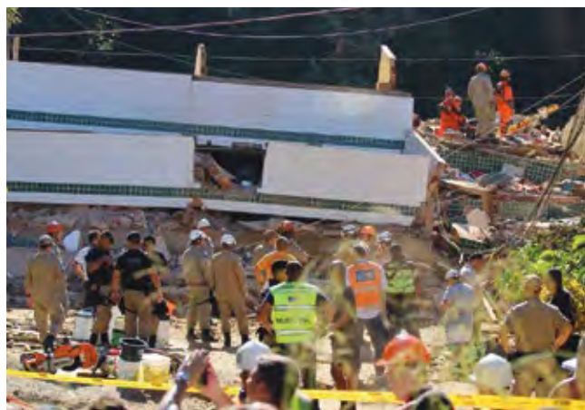
Prédios da Muzema, Zona Oeste - Rio de Janeiro/2019
