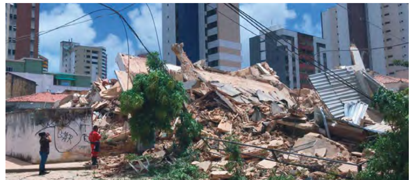
Edifício Andréia, Fortaleza-CE, dia 15/10/2019 - até o fechamento desta edição, 2 mortes e 9 desaparecidos- aparentemente falta de manutenção predial junto com falta de atualização dos sistemas construtivos. As investigações estão em andamento.
