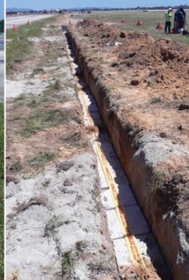
Preparação para reaterro das valas (Obra: Aeroporto de Fortaleza)
