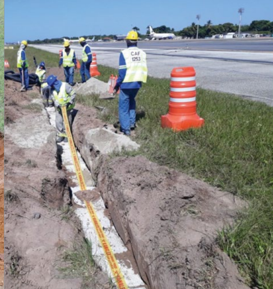
Colocação de fita de advertência
