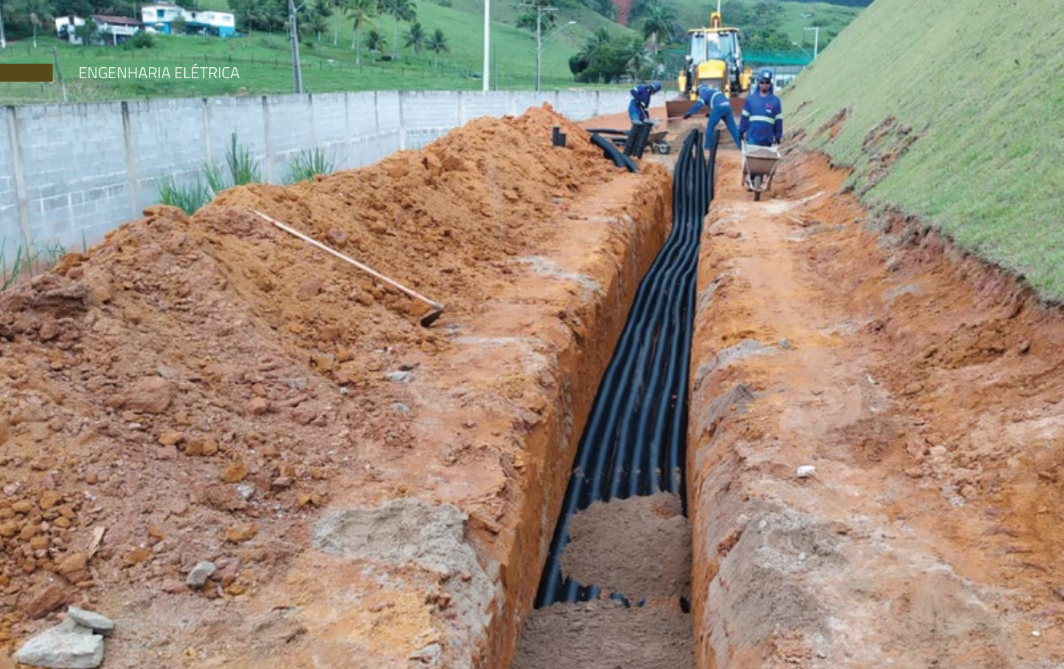
Instalação dos dutos na vala (Obra: Itaesbra)
