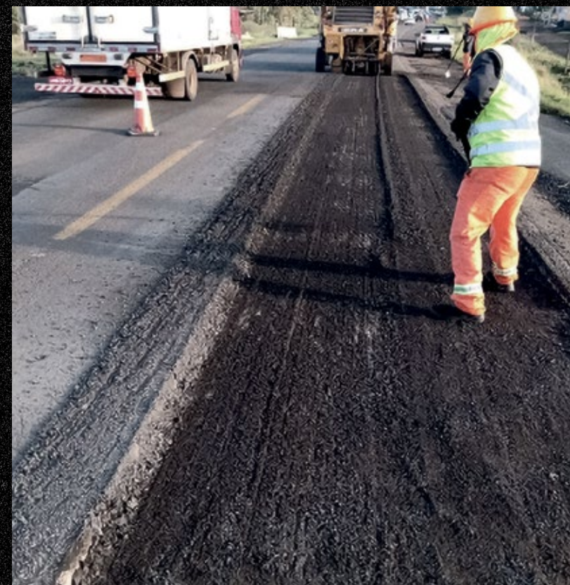
Reciclagem (Fresagem e Acabamento)
