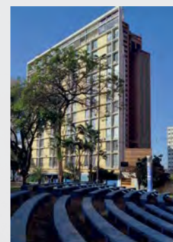
Título: Edifício Júlio Fuganti Autor: Wanderley Tolomi
