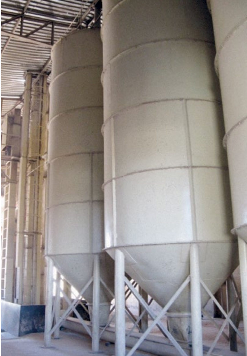
Figura 1 – Silo de uma fábrica de ração com enrijecedores verticais e horizontais.
