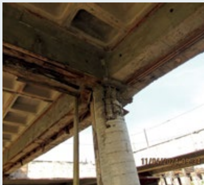
b) Nichos de concretagem em pilar
