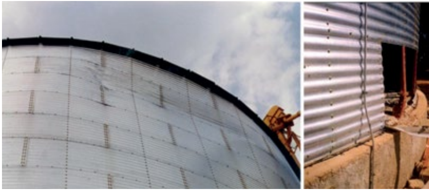
Figura 5 – (a) Instabilidade devido à ação do vento. (b) Vinculação não prevista em projeto.
