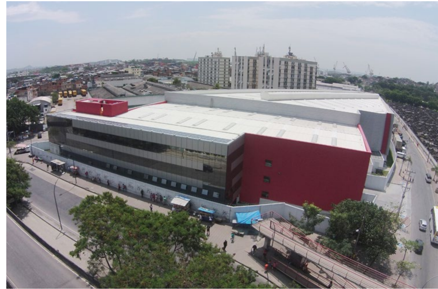
Centro de distribuição no bairro do Caju, no Rio de Janeiro. Coca-Cola Andina
