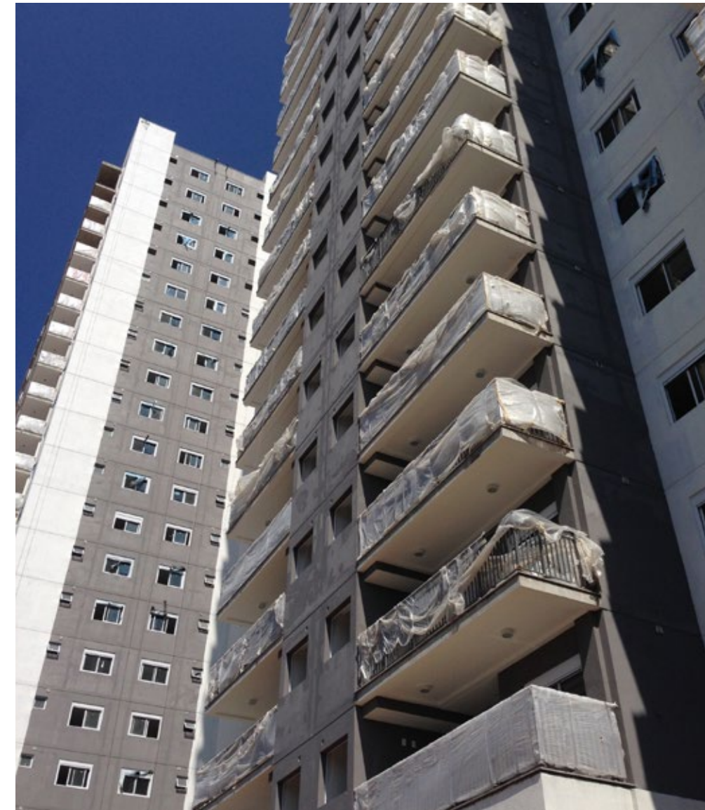
Sistema de fachada em concreto moldado “in loco” atendendo aos requisitos da ABNT NBR 15575
